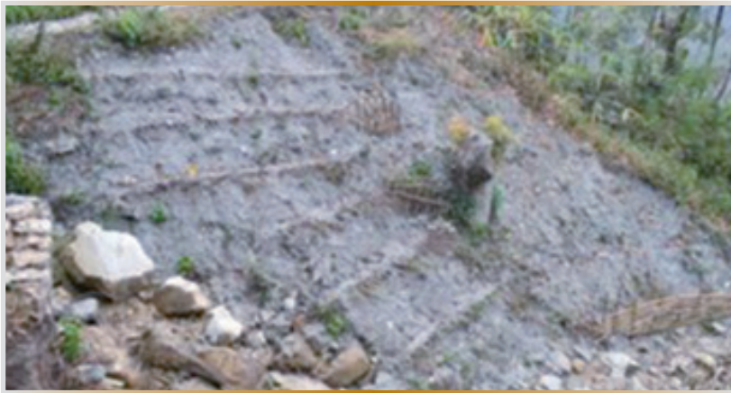
चित्र ११क : पर्वतको सडक किनारमा भू-जैविक प्रविधिबाट गरीएको भिरालो व्यवस्थापन। फोटो: सञ्जय देवकोटा, २०१४।
