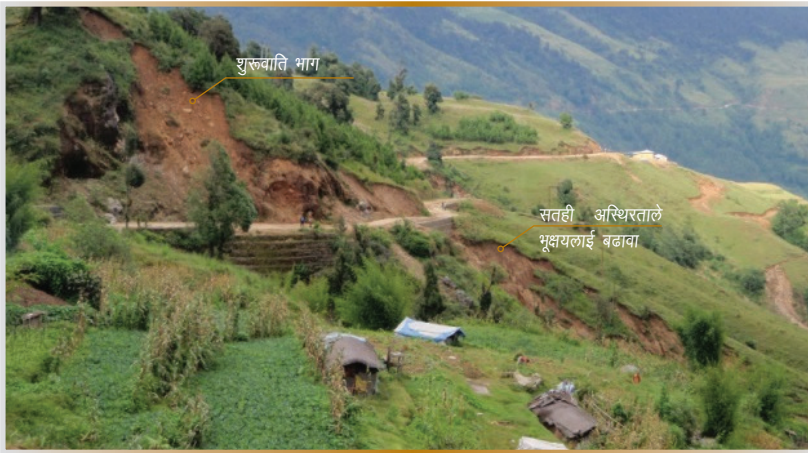
चित्र ५क : तेह्रथुम जिल्लाको बसन्तपुर क्षेत्रको सडक किनारमा उत्पन्न अस्थिरता । फोटो: K. Sudmeier-Rieux, 2009 ।
