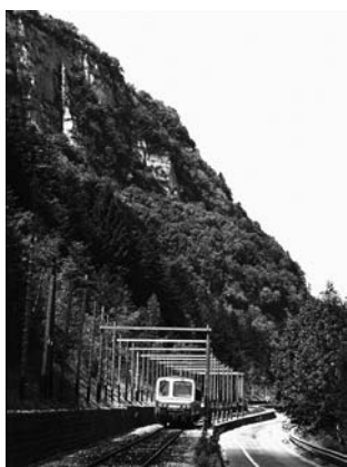
Figure 6.—Filets de détection (Nantua); photo Pascal Bejui.
