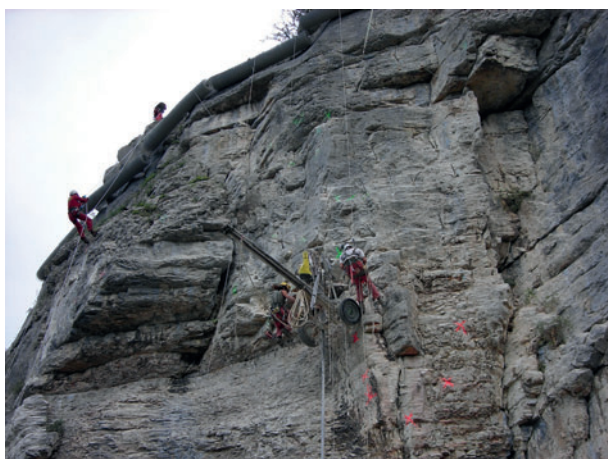
Figure 10.—Réalisation de tirants passifs (Bolozon); photo BG / Hugues Foltzer.
