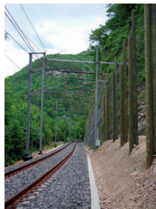
Figure 13.—Filets de détection verticaux et horizontaux (La Crotte); photo BG / Hugues Foltzer.
