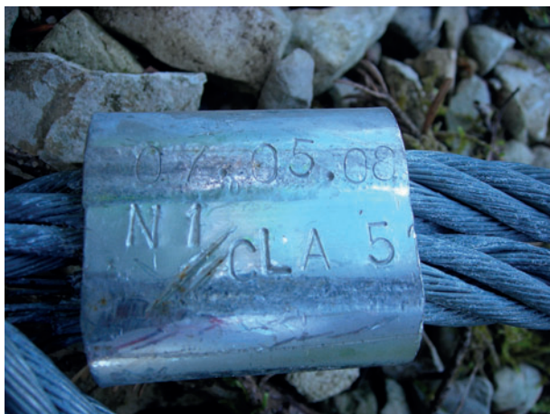
Figure 14.—Marquage des câbles façonnés (Sylans); photo BG / Hugues Foltzer.
