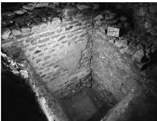
Abb. 51: Meikirch - Kirche 1977. Die Mauer 256 (hinten links) enthält zwei Lagen von Ziegeldurchschüssen (zweite und vierte Lage von oben). Gut sichtbar ist der Fugenstrich, der oberhalb des Vorfundamentes mit Verputz überdeckt war. Blick nach Nordwesten.
