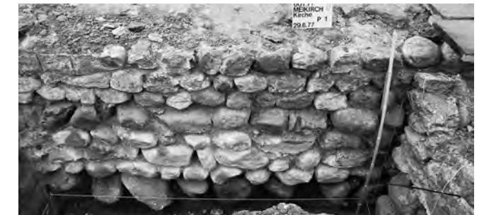
Abb. 26: Meikirch - Kirche 1977. Mauer 201, Südfront. Die untersten Fundamentsteine wurden unvermörtelt in den Mauergraben gestellt. Das darüberliegende Fundament besteht aus regelmässigen Steinlagen. Blick nach Norden.
