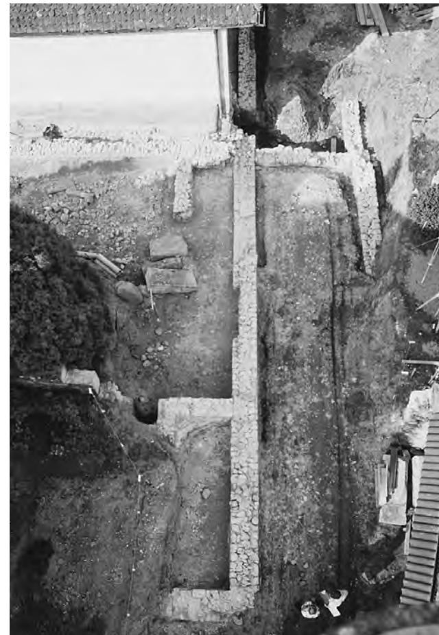
Abb. 25: Meikirch - Kirche 1977. Westlich der Kirche werden nur die Mauerkronen freigelegt. In der Bildmitte verläuft die Südmauer 201 des Hallenhauses. Links davon liegen die Treppenhäuser 4 und 5, rechts davon die Portikus 6. Blick nach Osten.
