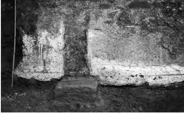
Abb. 45: Meikirch - Kirche 1977. Kryptoportikus 15. Im Bereich der Sockel ist die Bemalung der Nordwand ausgespart. Die Unterkante des Wandverputzes reicht bis auf das Bauniveau. Blick nach Norden.
