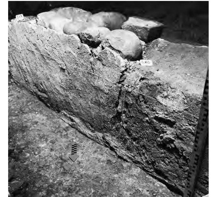
Abb. 24: Meikirch - Kirchgemeindehaus 2000. Mauer 70. Der mit pfanzlichen Bestandteilen versetzte Grundverputz ist grob mit der Kelle verstrichen. Am Bodenansatz ist der zweilagige Feinverputz 87 erkennbar. Blick nach Südwesten.
