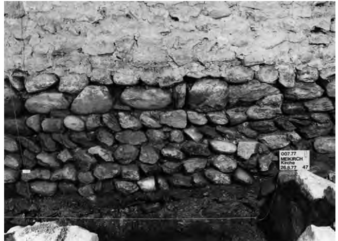
Abb. 231: Meikirch - Kirche 1977. Romanische Kirche. Fundament der Südwestwand des Kirchenschiffes. Blick nach Süden.
