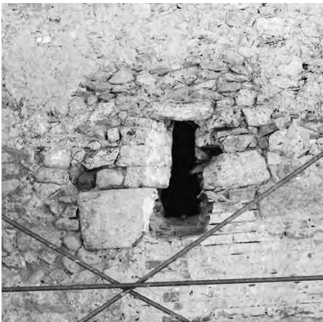
Abb. 235: Meikirch - Kirche 1977. Fenster in der Südmauer. An der Innenseite zeichnet sich über einem heute vermauerten Fenster ein Rundbogen ab; an der Aussenfassade (unten) liegt über der Fensteröffnung ein Steinsturz.
