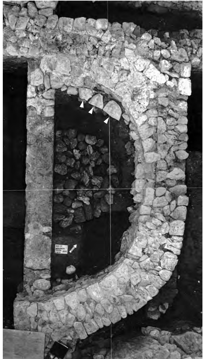
Abb. 218: Meikirch - Kirche 1977. Kirche I. Reste des Altarfundamentes und der Apsis. Letztere liegen entlang der Innenseite der romanischen Apsis. Senkrechtaufnahme, Norden oben.
