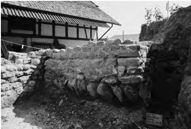
Abb. 29: Meikirch - Kirche 1977. Die Mauer 207 (rechts) stösst an Mauer 201 (links) an. Dabei liegt die erste Lage des aufgehenden Mauerwerks der Mauer 207 auf dem Vorfundament der Mauer 201 auf. Blick nach Südwesten.
