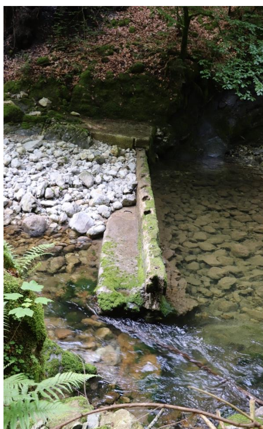
Figure 10. Fondations d'une ancienne dérivation hydraulique (pour un moulin ?) (secteur aval, canton de Fribourg). Cliché : S. Flaminio, 2023
