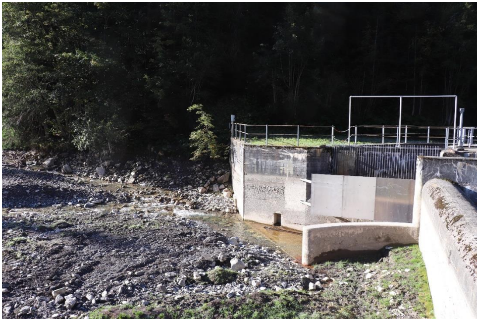
Figure 7. Prise d'eau de la Torneresse. Cliché : S. Flaminio, 2022
