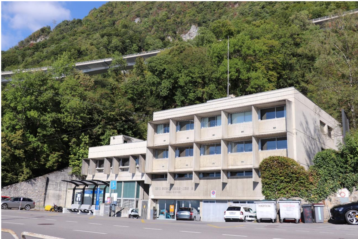
Figure 18. Entrée des centrales de Veytaux I et II. Cliché : S. Flaminio, 2022
