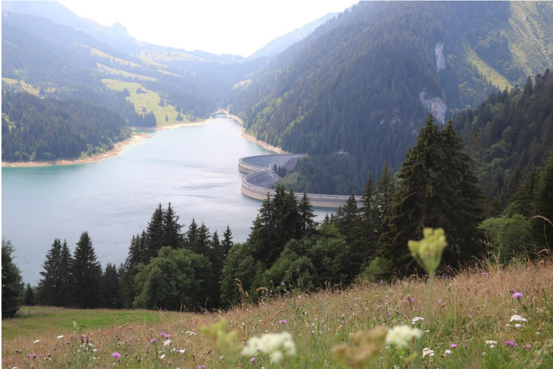
Figure 16. Le barrage de l'Hongrin. Cliché : S. Flaminio, 2020
