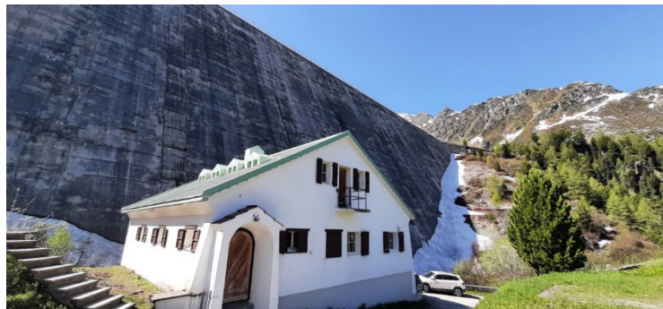
Figure 7. Le barrage de Cleuson depuis le pied du mur. Cliché : S. Flaminio, 2021
