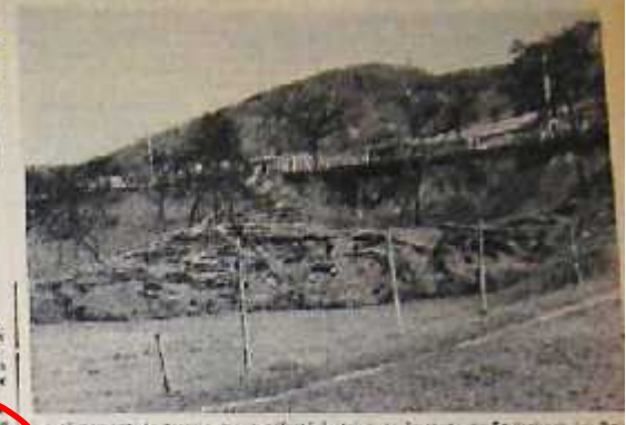
glissement de terrain qui a effondré le toit de la route de Soultzba... compromis la solidité de la digue... La terre dans son mouvement de translation et n'a pu résister... (photo: L. Alster)
